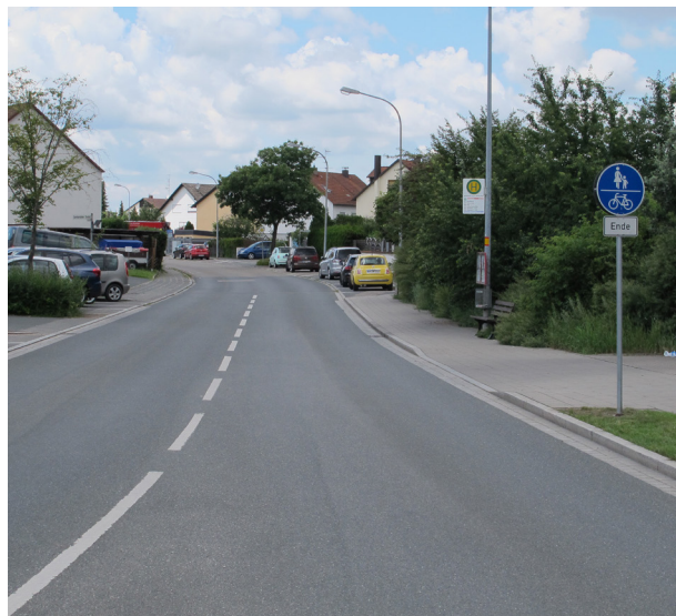
- abrupt endender Radweg ohne Weiterführung auf Straße
