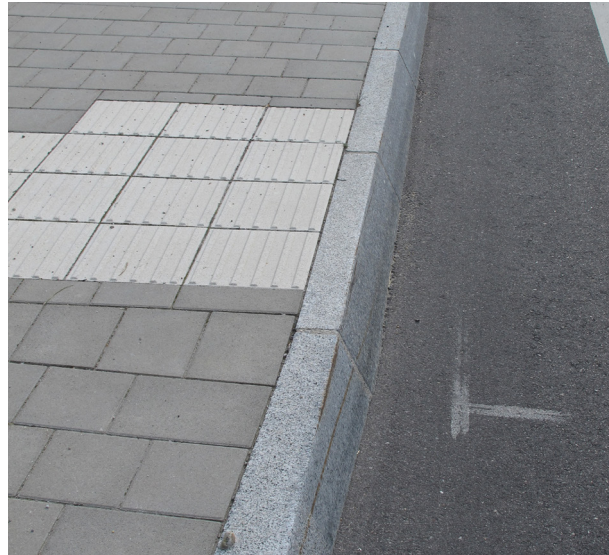
+ Blindenleitsystem an Bushaltestelle
